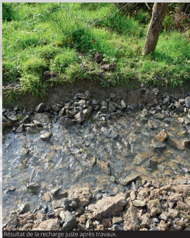
Résultat de la recharge juste après travaux.
