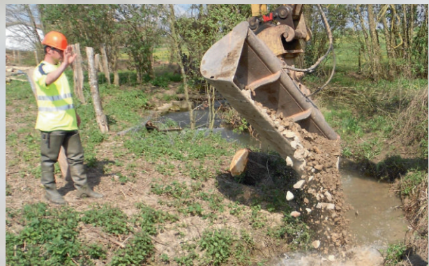
Un godet inclinable permet d'avoir un effet "bec verseur" et de disposer la recharge avec plus de précision. On gagne encore en souplesse de mise en œuvre et en précision avec un godet orientable à 360° car la dépose et le modelage des matériaux sont indépendants de la position de la pelle. Ils limiteront ainsi les mouvements de celle-ci. Les travaux de remise en état seront d'autant réduits.
