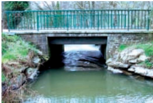
Rehaussement du radier sous le pont - vue de l'amont
