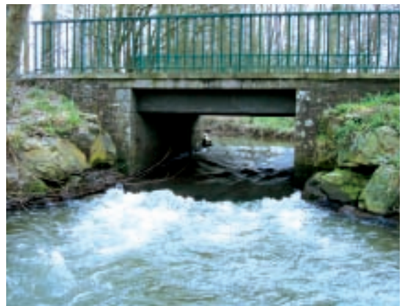
Rehaussement du radier - vue de l'aval
