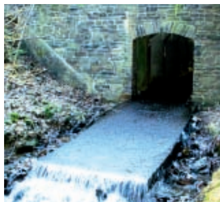
Dalle de béton inutile !
