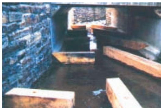
Principe des déflecteurs type offset
