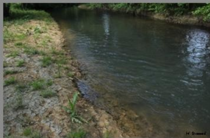
Exemple de redressement de la bordure d'une banquette en matériau très cohésif (argile)
