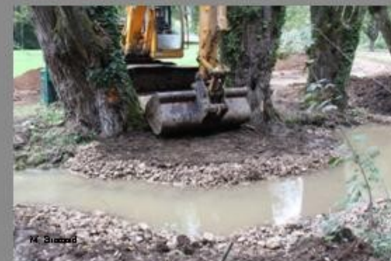
Pose de terre derrière un cordon pierreux
