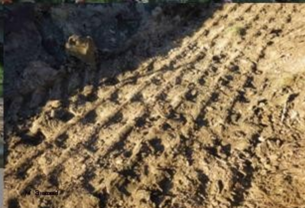
Terre argileuse compactée au «Pied-de-mouton»
