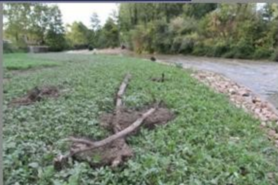
Les laisses de crue permettent de penser à un bon calage et une bonne dispersion d'énergie
