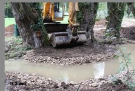
Pose de terre derrière un cordon pierreux
