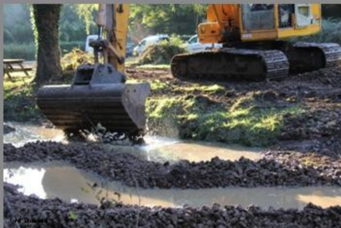
cordon de granulats grossier, remblaiement de terre derrière
