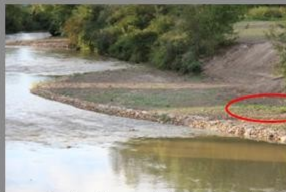
érosion localisée au droit d'une aspérité
