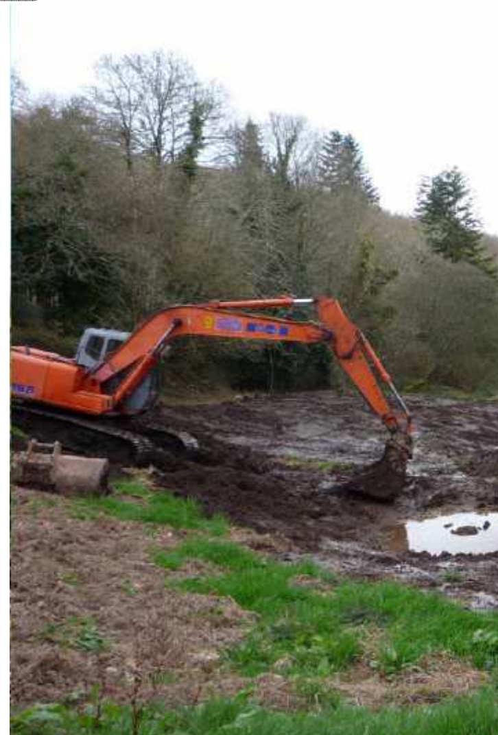
Restauration de mare
