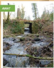
Chute infranchissable dans l'ouvrage (1,30m), suivi d'un élargissement du lit dû à l'énergie de la chute, créant une retenue sédimentaire en amont et une lame d'eau diffuse et peu profonde en aval de l'ouvrage.
