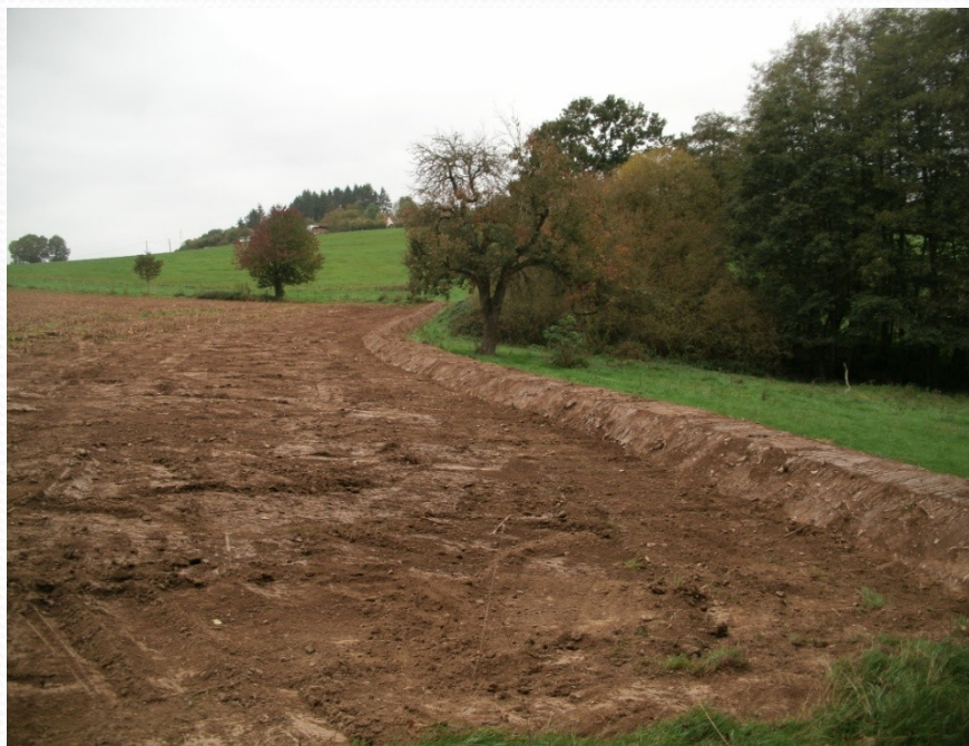
Création de talus
