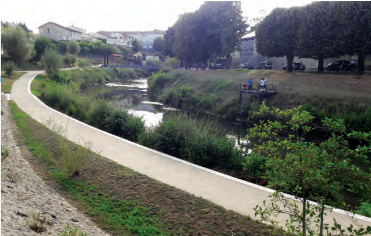
Voie aménagée sur les bords de la Midouze
