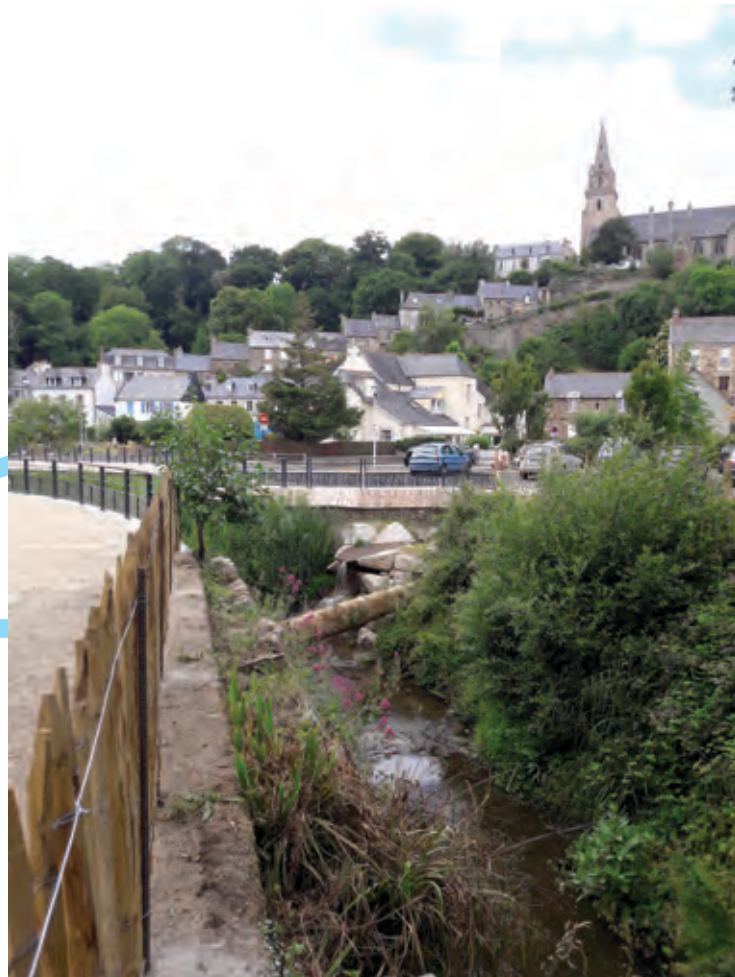
APRÈS Fin des travaux (Juin 2017)
