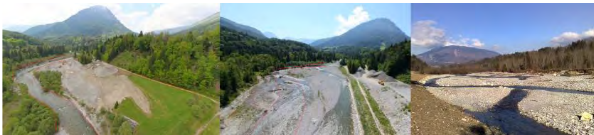
Figure 113 Photos du site restauré, de gauche à droite : début des travaux (avril 2010), fin des travaux (juin 2010), février 2011 (photos extraites de Jund et al., 2012)
