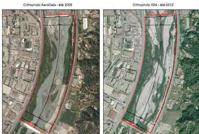
Figure 117 Progression des sédiments à l'aval du seuil 9 suite aux travaux d'abaissement (photo extraite de Département 06, 2015)
