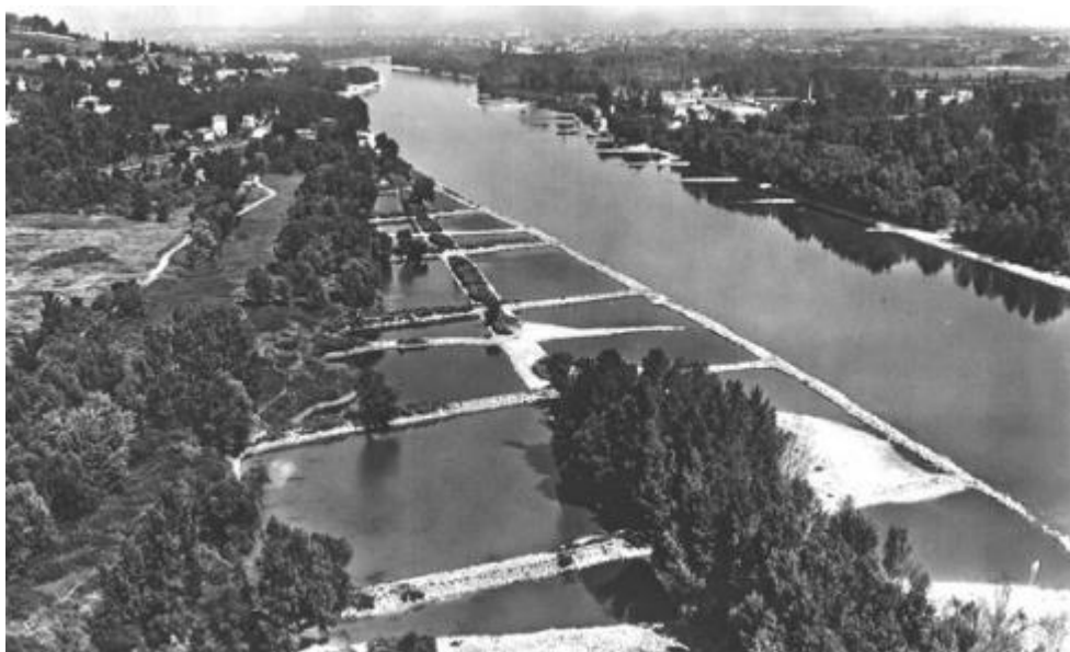
Figure 1 Exemple d'aménagements Girardon sur le Rhône (SMIRIL, n.d.)
